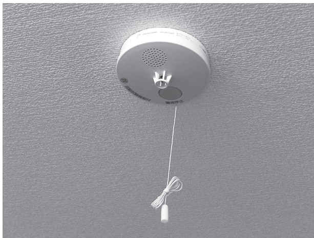
住宅用火災警報器(代表例)
