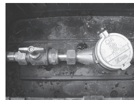
屋外の水道メーターボックス内の 水道の元栓(代表例)
