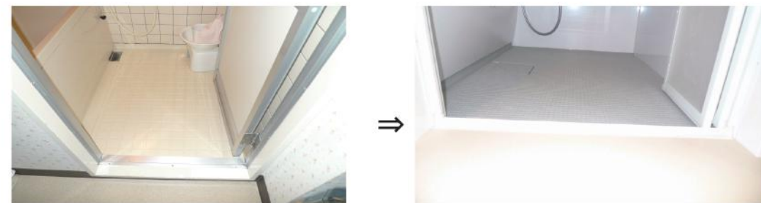
浴室入口の段差の解消
