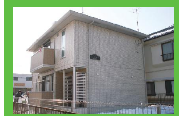
「レトワール」(大和ハウス施工) 池田さんが新築した「レトワール」。最新のセキュリティを備え、アパート生活に付きものの生活音をシャットアウトする防音素材を導入。日々変わる入居者様のニーズを捉えた物件で、完成前に満室になった物件です。
