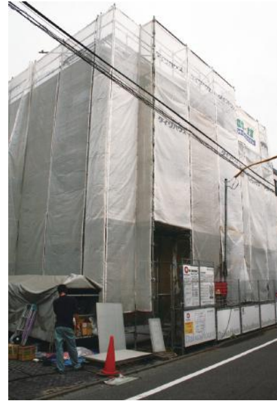
建築中の3階建てマンション
